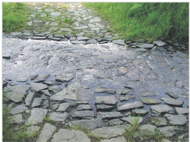
Рис. 4.4-14. Найстаріша форма перетину шляху з водоймою — мілина — знову набуває значення, якщо цьому не перешкоджають водотік і транспортне значення шляху (фото: Thomas)
