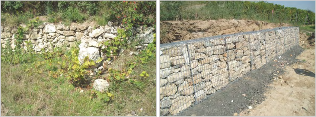
Рис. 4.4-30. Занедбані стіни сухої кладки (ліворуч) замінюються габіонами (каркасними сітками з дроту з гравійним матеріалом всередині) (праворуч) з огляду на навколишнє середовище й ландшафт (фото: Thomas)
