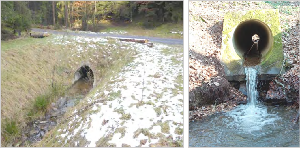
Рис. 4.4-13. Водопропускна споруда ліворуч на перетині з річкою має достатнє накриття й субстрат основи; жолоб праворуч становить непереборну перешкоду для водної фауни (фото: Peter; Thomas)
