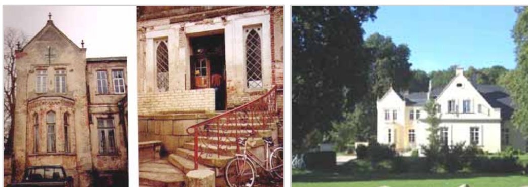
Abb. 5.4-3: Burg Bassewitz vor und nach der Restaurierung (Quelle: SALUM)
