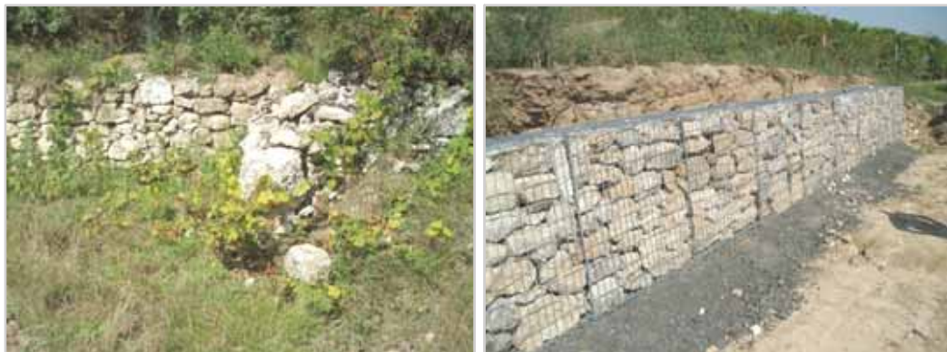
Abb. 4.4-30: Verfallene Trockenmauern (links) werden durch Gabionen (rechts) umweltverträglich und der Landschaft angepasst ersetzt (Foto: Thomas)
