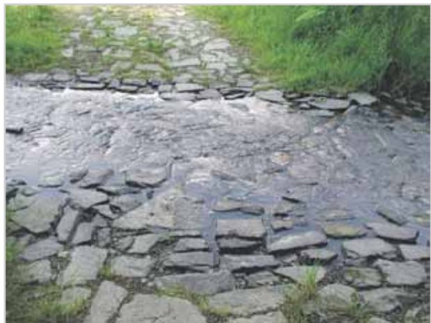
Abb. 4.4-14: Die älteste Form der Kreuzung eines Weges mit einem Gewässer, die Furt, gewinnt wieder zunehmende Bedeutung, wenn das die Wasserführung des Gewässers und die Verkehrsbedeutung des Weges zulassen (Foto: Thomas)
