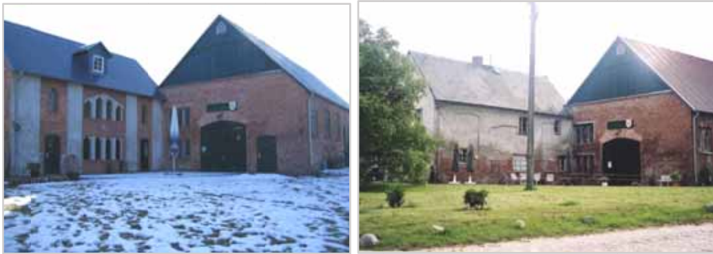
Abb. 5.4-7: Hofladen vor und nach der Restaurierung (Foto: SALUM)
