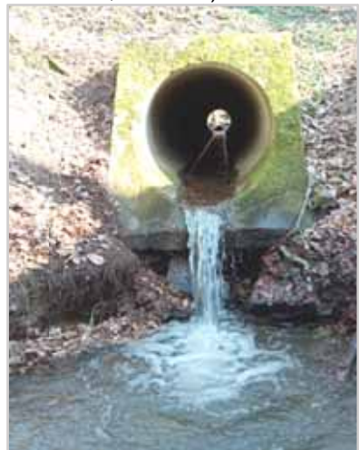
Abb. 4.4-13: Der Durchlass links zur Querung des Fließgewässers hat ausreichend Überdeckung und Sohlsubstrat; der Durchlass rechts stellt eine unüberwindbare Barriere für die Gewässerfauna dar. (Foto: Peter; Thomas)
